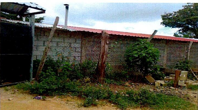
Foto 5: MEJORMIENTO DE MURO DE CONTENCIÓN
