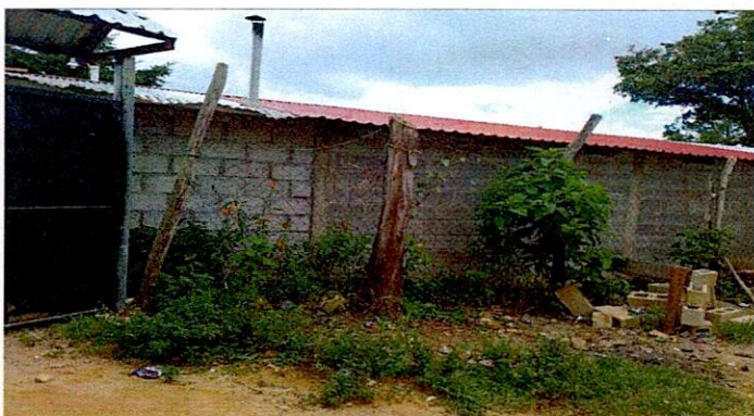
Foto 4: MEJORMIENTO DE MURO DE CONTENCIÓN
