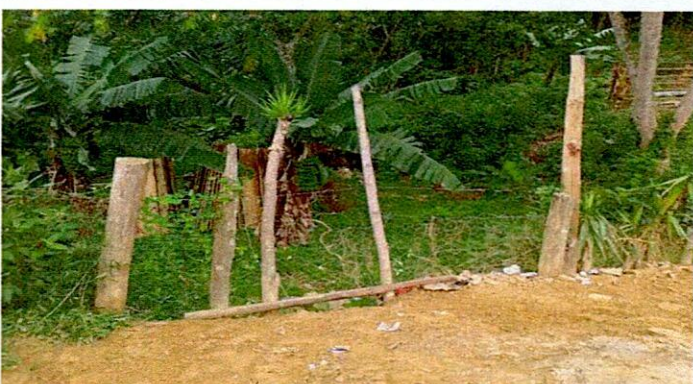
Foto 6: MEJORMIENTO DE MURO DE CONTENCIÓN
