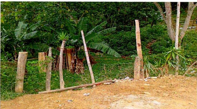
Foto 3: MEJORMIENTO DE MURO DE CONTENCIÓN
