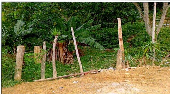
Foto 2: Mejoramiento de muro de Contención
